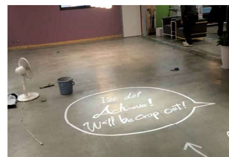
店舗・施設内装
