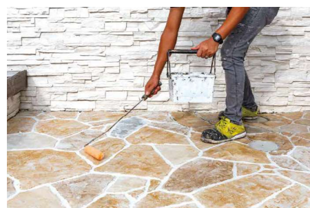
スピード施工
