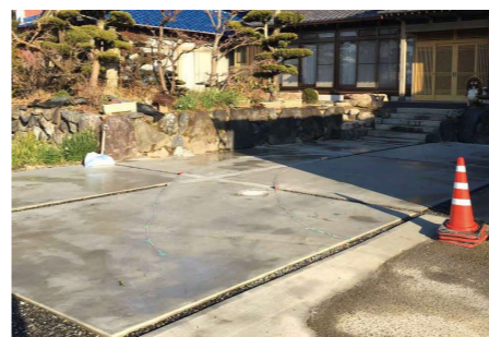
土間コンクリート
